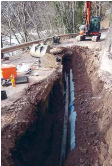
Die Trink- und Löschwasserleitungen werden in Hinterfang mit den Jekon-Bewässerungsrohren mitverlegt.
